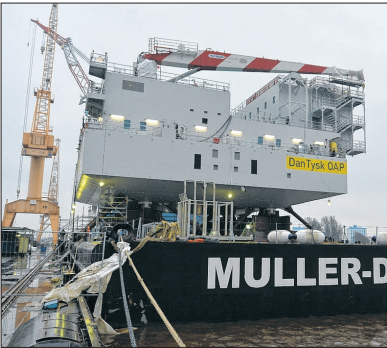
Die Wohnplattform für die Offshore-Mitarbeiter wird in Emden gebaut.
